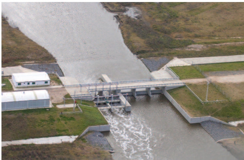
Obra de control de inundaciones.
