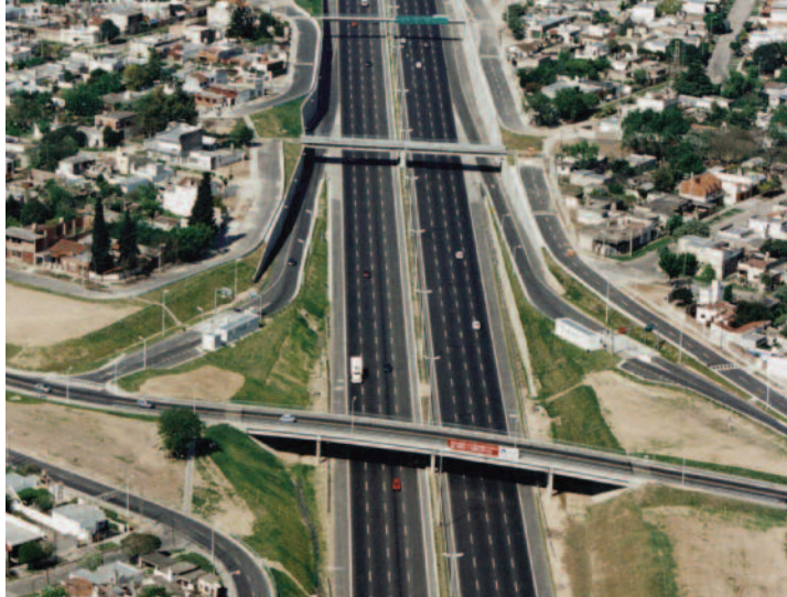
Accesos a centros urbanos.
